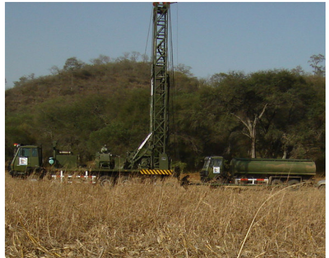
Equipo de perforación, para la extracción de Agua.
